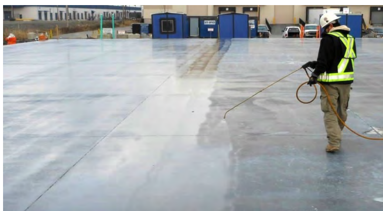
Figur 1.2 – Membranhärdning av nygjuten betongplatta.
