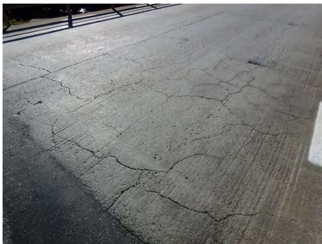
Figur 1.1 – Exempel på plastiska krympsprickor i brobanepaltor.
